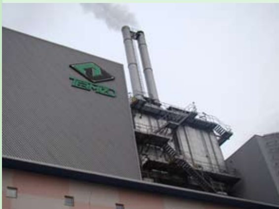
Spalarnia odpadów komunalnych w Libercu
